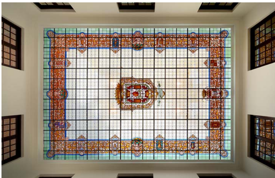
Vidriera del patio interior.
